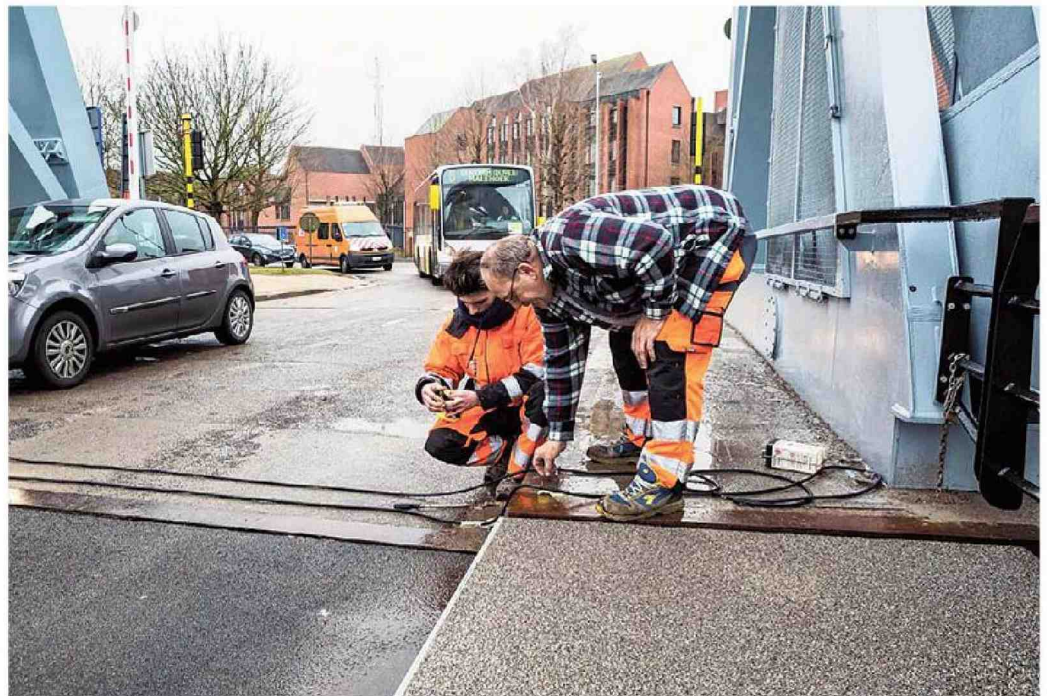
Arbeiders leggen meetapparatuur aan op de tijdelijke Kruispoortbrug. (Foto Davy Coghe)
